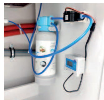
Exemple de lieu de fixation de l'indicateur
